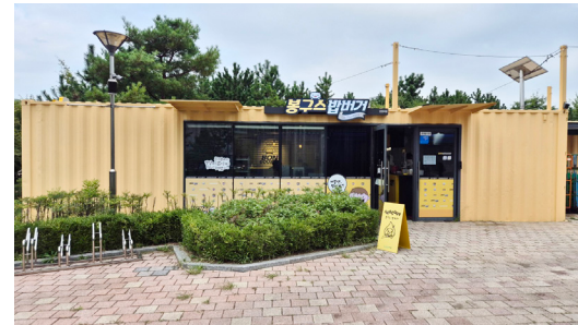
봉구스밥버거 인천대점 시공 (2024.10)
